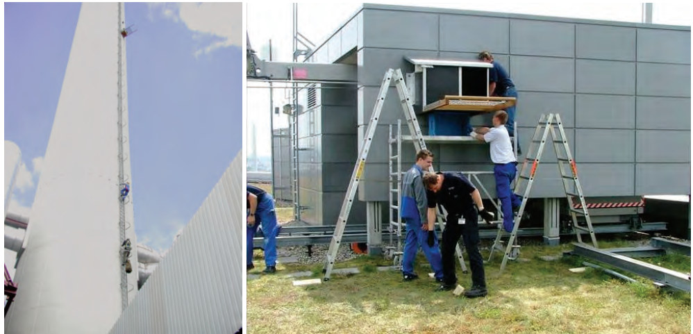
Abb. 15 und 16: Beschwerlicher Aufstieg zum Wanderfalkennistkasten an einem der Kraftwerksschornsteine (links); Auszubildende montieren einen weiteren Wanderfalkenkasten (rechts)
