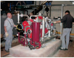
Abb. 36: Einbau des Motor-BHKW in der Realschule Hinterweil
