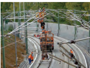
Abb. 49: Fahrdrähte im Bereich Lindenstraße werden montiert. Am rechten Bildrand ist die Gabionenwand erkennbar.
