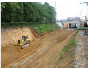
Abb. 47: Planie für das neue Gleisbett im Bereich Lindenstraße
