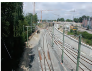
Abb. 48: Neuverlegte Gleise und die Träger der Oberleitungen im Bereich Hanns-Martin-Schleyer-Straße
