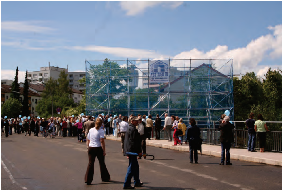
Abb. 53: Schaugerüst zur Visualisierung der Höhe der geplanten Lärmschutzwände auf dem Goldberg
