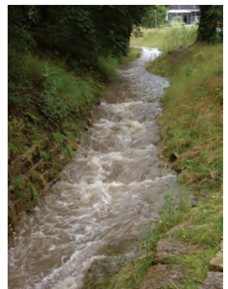
Abb. 59: Neue Sohlrampe bei Hochwasser, Juli 2009
