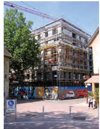
Abb. 78: Im Bau befindliches „City Cube“ am sanierten Standort Untere Vorstadt 5
