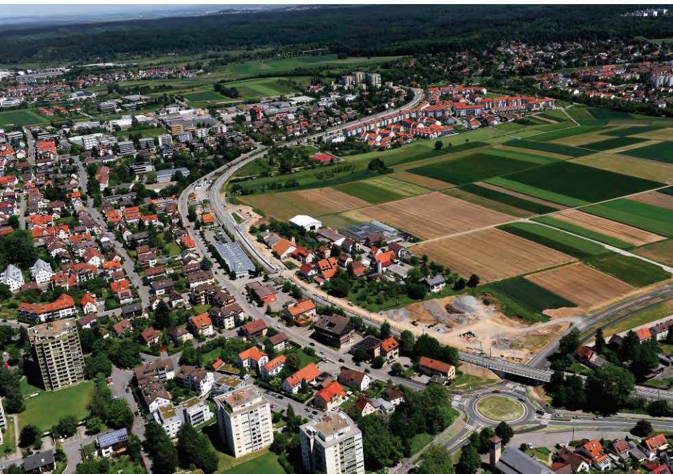
Abb. 71: Blick auf das Gewinn Allmendäcker; mit dem ersten Bauabschnitt werden ca. 12 ha, mit dem zweiten ca. 8 ha landwirtschaftliche Flächen in den kommenden Jahren überbaut.
