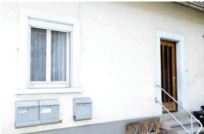
Ganzheitlich sanieren: Wird die Fassade erneuert, ...
