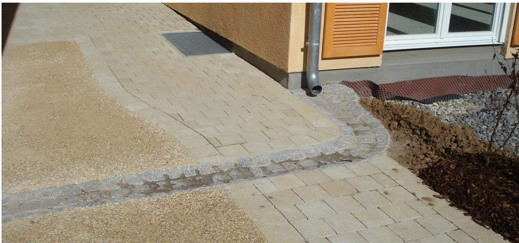
Abb. 64: Offene Ableitung des Niederschlagswassers
