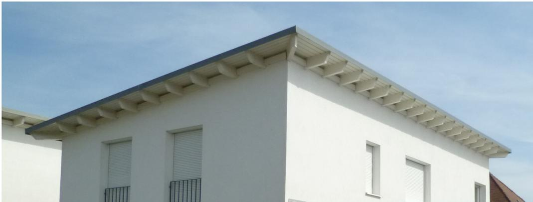
Abb. 22: Pultdach mit weit auskragendem Dachrand
