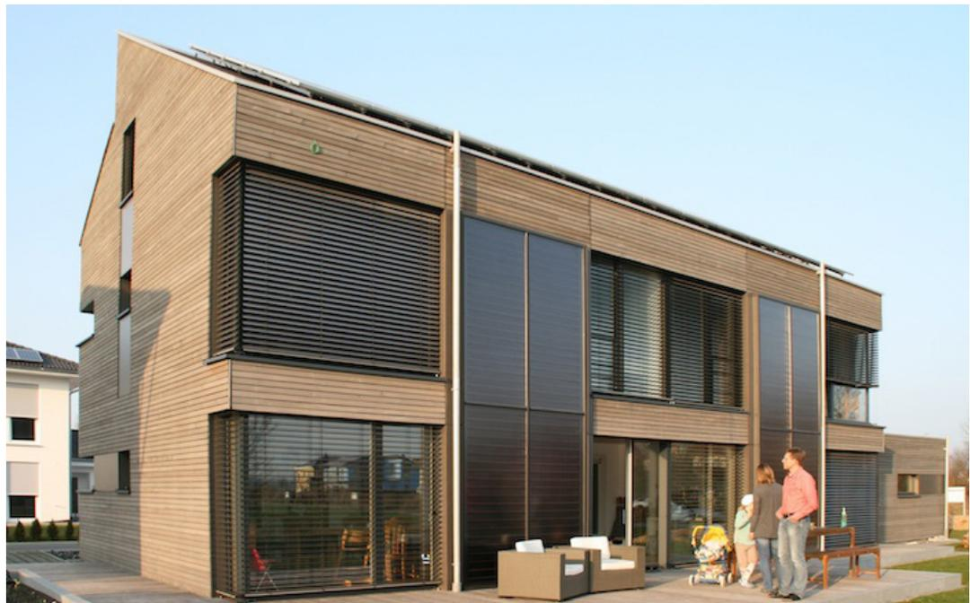
Abb. 33: Holzbauweise, fassadenintegrierter Solarkollektor, Sonnenschutz
