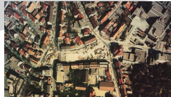
Bau der Marktplatz Tiefgarage
